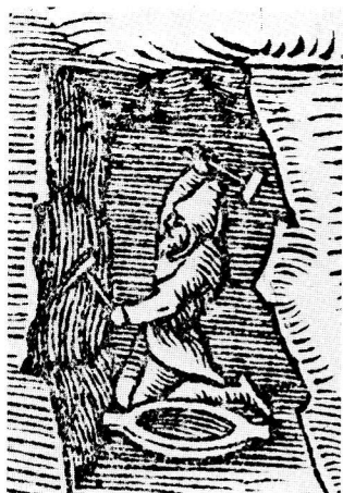
18 Schrämmarbeit nach Agricola, 1546.
