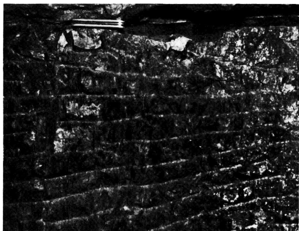
19 Schrämmspuren im Stollensystem «Obermadlein» in S-charl.
