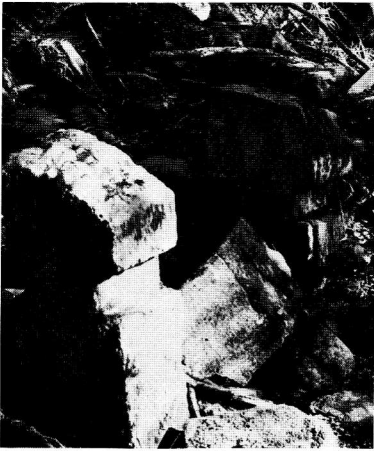
30 Widerlagerböcke für einen Schmelzdehammer in der Schmelze Ausserferrera.
